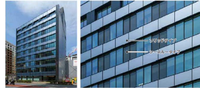
リニューアル① 外壁のスパンドレル部にソリッドタイプ、執務室窓にはシースルータイプを採用
